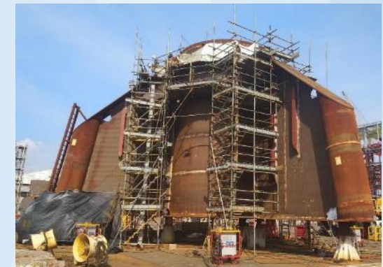
轉接段銲道缺陷修補
