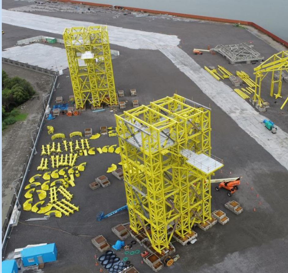
大組1施工塔架
