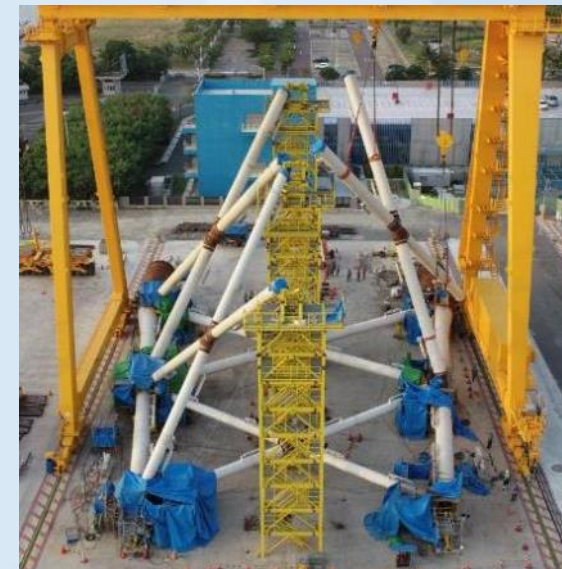
下部結構3D組鋸中
