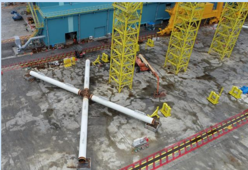
斜撐運至下部結構組鋸區定位
