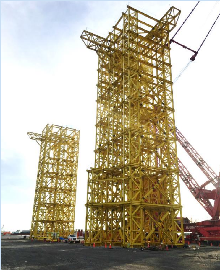
大組2施工塔架
