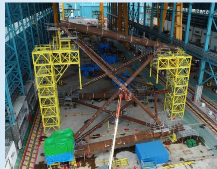
上結構3D組鐸完成
